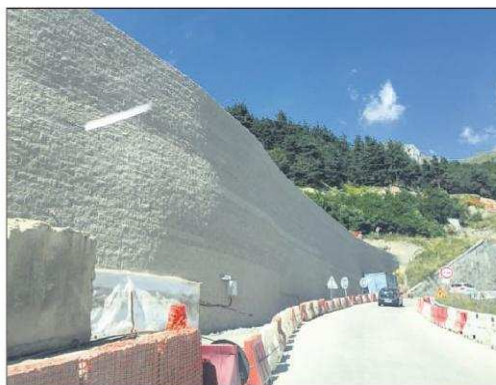
Le mur de soutènement qui inquiète est situé à quelques centaines de mètres de l'entrée du tunnel côté français.
